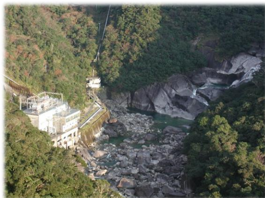
安房川第一発電所
