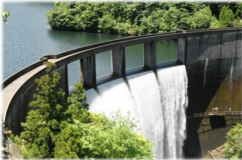
尾立ダム (中央越流式アーチダム)
